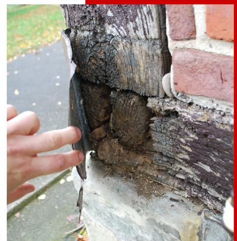
Fachwerkschwellen werden als gefährdete Bauteile besonders genau untersucht.
