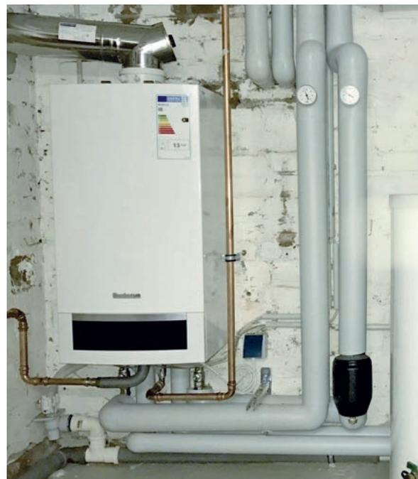
Das linke Bild zeigt die alte Gas-Niedertemperaturheizung vor dem Kesseltausch. Rechts ist die neue und moderne Gas-Brennwertheizung zu sehen.
