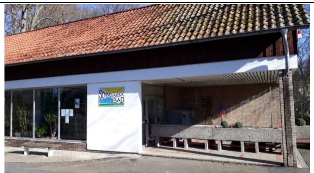
Sicht auf den Ausgang, der zum schwellenlosen Eingang werden soll sowie Blick auf den Bereich, in dem die Sanitäreinheit für Rollstuhlfahrer entstehen soll. (© Hein 2010)
