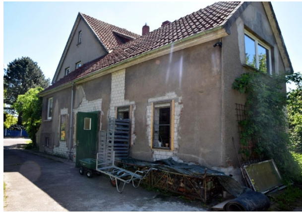
Aktueller Hofladen, Außenansicht. Links hinten die Straße. Der geplante Keller-Zugang befindet sich rechts hinter dem Haus. (Wiegand 2019)
