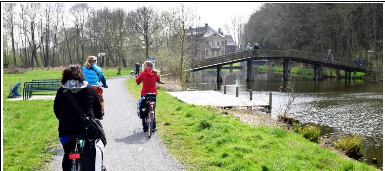
Die 19%-ige Steigung der derzeitigen Brücke zwingt viele Radfahrer zum Absteigen und Schieben. Für Rollstuhlfahrer oder weniger mobile Menschen ist sie nicht zu bewältigen. (Foto: Wiegand, 2015)
