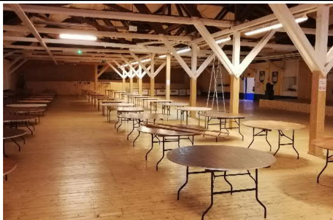
Liethhalle Innenansicht (Wiegand 2020)
