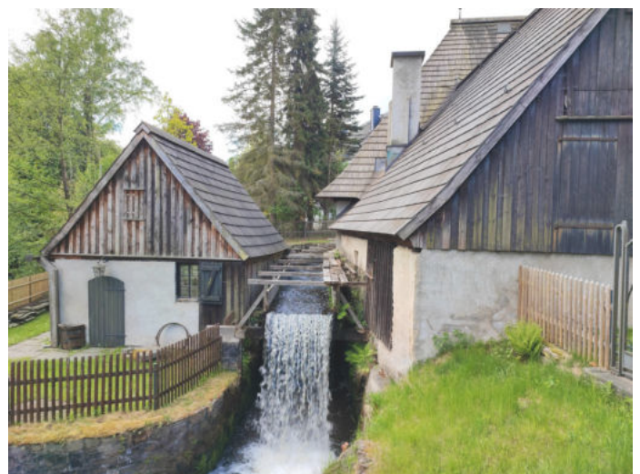
Abb. Die Schmiederei - Außenansicht
