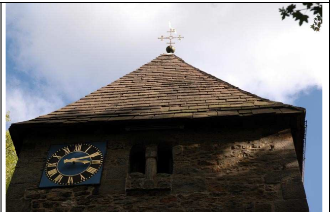
Turmdach von Westen
