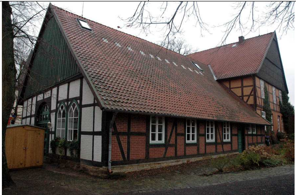
Links das Pfarrbauernhaus von 1550 mit dem zu sanierenden Holzgiebel, rechts das Wohnhaus von 1713
