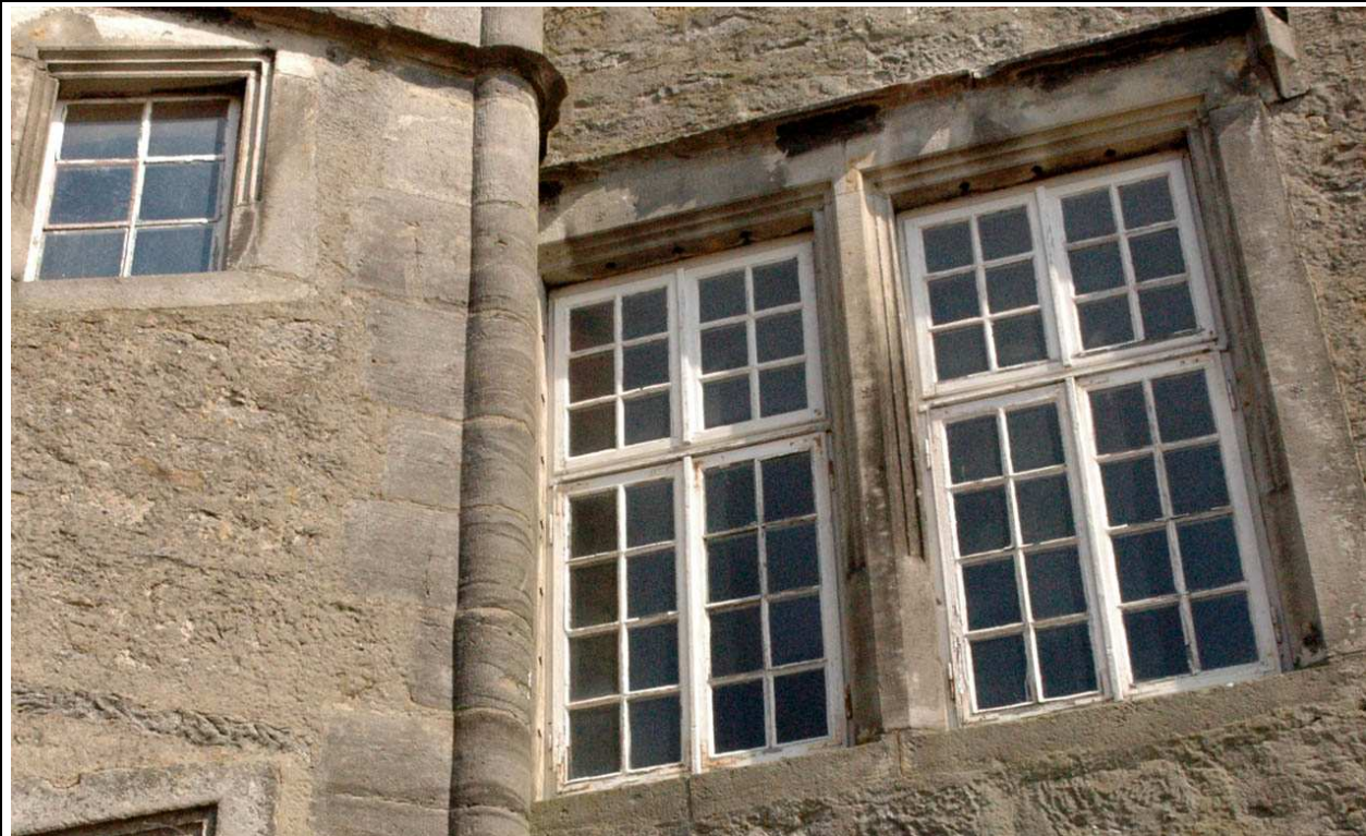
Fenster an der Nordwestseite
