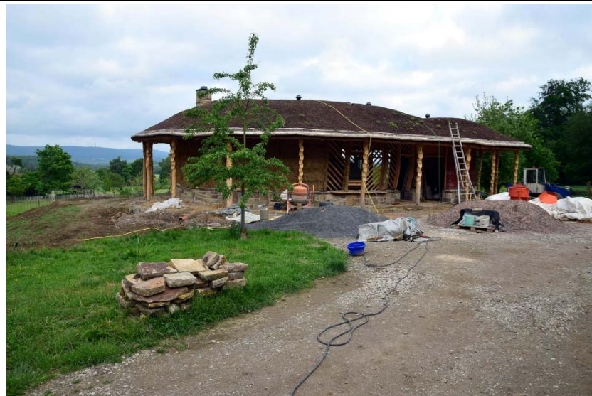
Das Bienenhaus im Rohbau. Im Vorderrund die bisherige Zuwegung. (© Wiegand 2016)
