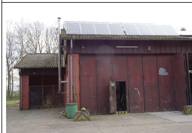
Abb. 4: Außenansicht von Westen auf das alte Eingangstor (© WASS 2018)
