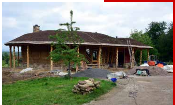
Das Bienenhaus (hier noch im Bau) bekommt eine barrierefreie Zuwegung
