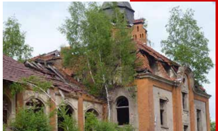
Die „Kohlenkirche“ am Georgschacht ist ein bedeutendes Industriedenkmal
